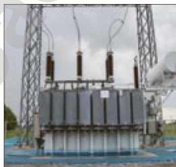
253-сурет. Қосалқы стансыдағы күш трансформаторы
