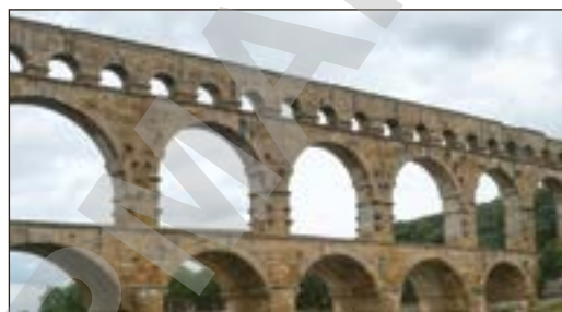
54-сурет. Пон-дю-Гар – көне римдік акведук (су берілетін канал). Ремулан маңындағы Гар француз департаментіндегі Гардон өзені арқылы өтеді. Ұзындығы – 275 метр, биіктігі – 47 метр. ЮНЕСКО-ның бүкіләлемдік мұра-ескерткіші
