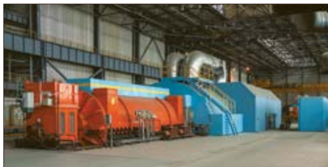
249-сурет. Электрстансының мәшине залы. Бу генераторы
