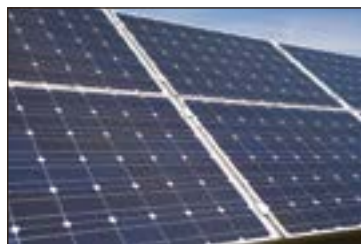
103-сурет. Монокристалдардан жасалған күн панельдері
