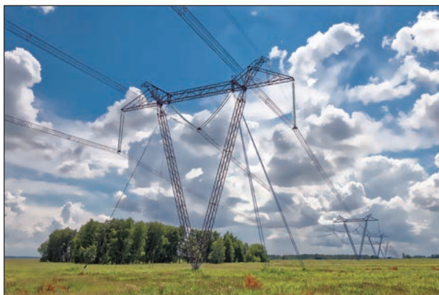
75-сурет. Жобалық кернеуі 1150 кВ «Екібастұз – Көкшетау» ЭТЖ-лері
