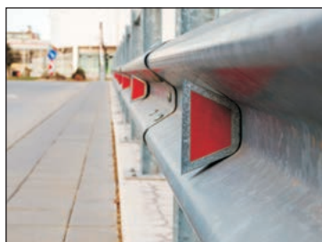
151-сурет. Еуропалық үлгідегі катафоттар мен сигнал бағаналары
