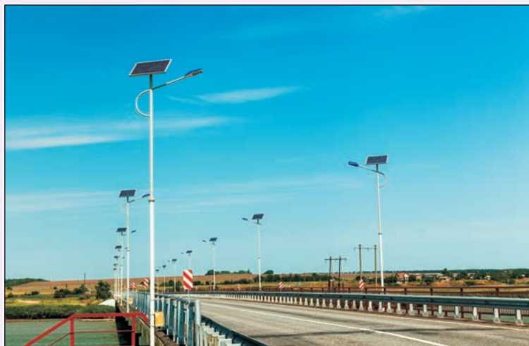
21-сурет. Күн батареялары бар көше шамдары
