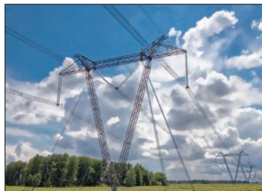
45-сурет. Жобалық кернеуі 1150 кВ болатын «Екібастұз – Көкшетау» ЭТЖ
